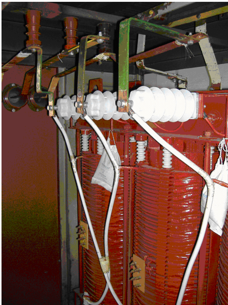
Slika 11: Rekonstruisan suvi transformator sa odvodnicima prenapona umesto potpornih izolatora
